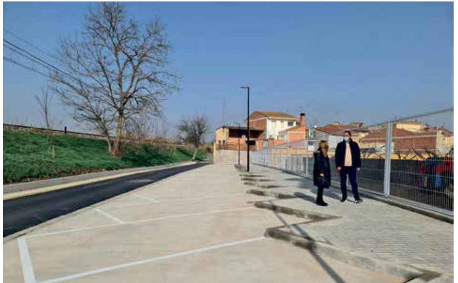
Alfonso Adán visitó las obras de la calle Ferrocarril con la aparejadora municipal.
